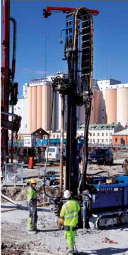
En Hütte 204GT fick snabbkallas för att klara den krävande borrhningen till geoenergianläggningen.
