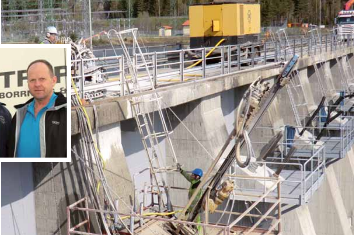
Borrning för spånt vid Bergforsens kraftverk utanför Sundsvall.
